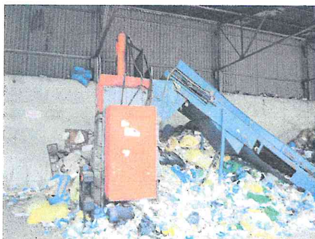
Fot. Nr 1 – widok ogólny;
