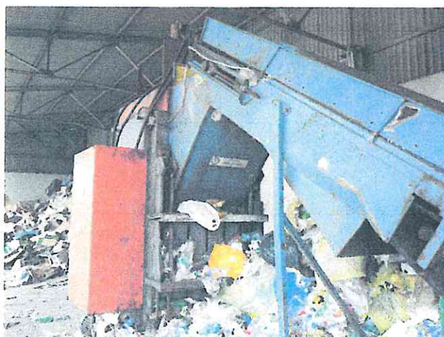
Fot. Nr 3 – widok ogólny;
